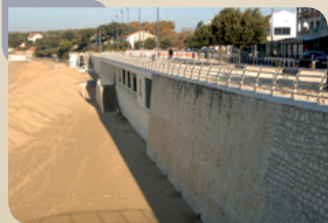
Digue maçonnée, Grande Plage de Fouras-les-Bains
