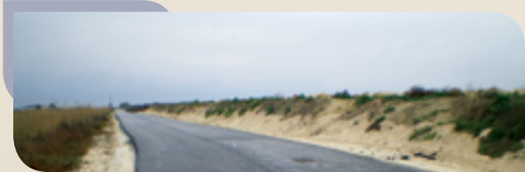
Digue à talus, Port-des-Barques (Montportail)
