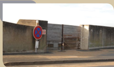
Batardeau installé à l'entrée de la plage de Châtelailon, destiné à clore l'accès à la mer
