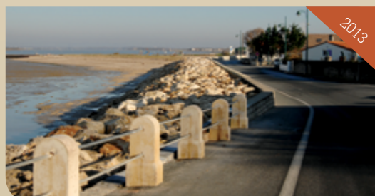
Protection de la digue maçonnée de l'avenue de l'Île Madame par l'ajout d'enrochements, Port-des-Barques, septembre 2013.
