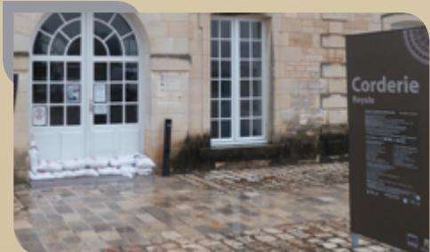
Sacs de sable placés à l'entrée du pavillon sud de la Corderie Royale
