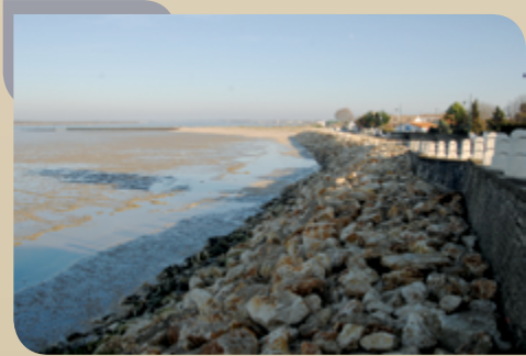
Digue enrochée, Port-des-Barques
