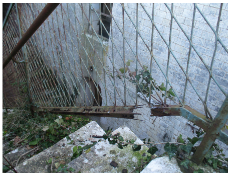
garde corps escalier fossé
