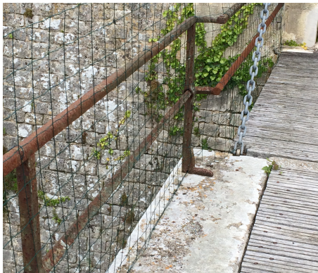
grillage rapporté sur le garde corps du pont levis
