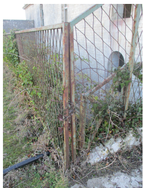
garde corps escalier sur fossé
